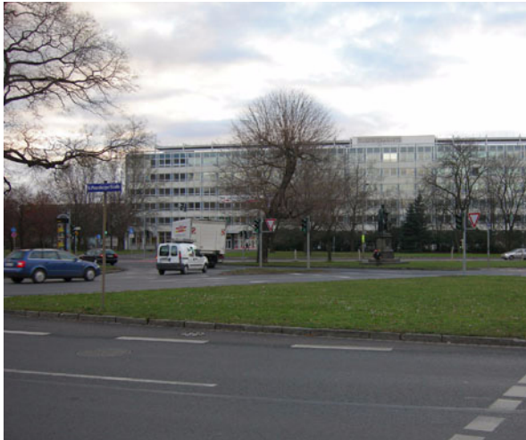
Abb.3: Ehemaliger Georgplatz, Foto: 2007.
