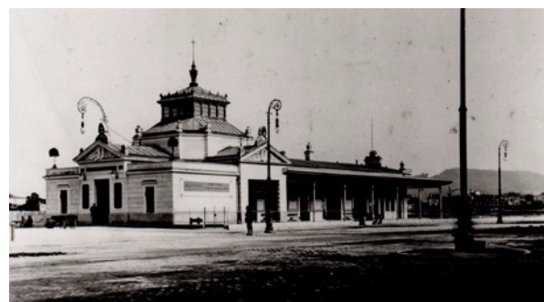
Abb.3: Das Bahnhofsgebäude der Lokalbahn. Abriss 1970er Jahre. Foto: Familienchronik Dioszeghy.
