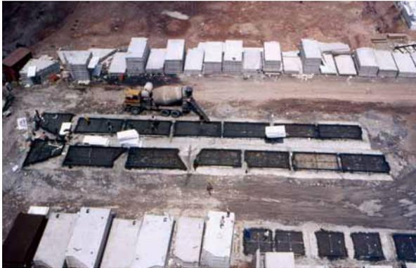
Abb.2: und Abb. 3: Venezuela, Cachamay, Bauten im Konstruktionssystem SIMIX, dieselben Teile in der Feldfabrik und bei der Montage, 1979: Die Fertigteilbauweise wurde von Nancy Dembo als ausgefeilte Methode vorgestellt, die zu Unrecht als *Architektur* missachtet wird, zumal sie als *Konstruktion* weiter lebt.
