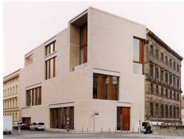
Abb.2: Galeriehaus Bastian, 2008 von David Chipperfield. Foto: Gerrit Engel 2009.
