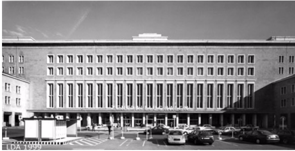
Abb.3: Flughafen Tempelhof, Eingangsgebäude, Foto: Landesdenkmalamt Berlin, 1999.
