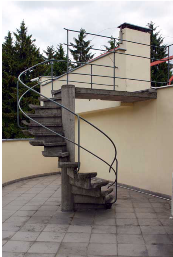
Abb.3: Hans Scharoun: Ledigenwohnheim der Werkbundsiedlung WUWA in Breslau 1929, Treppe zwischen den Dachterrassen, Aufnahme 2006 (Andreas Schwarting).
