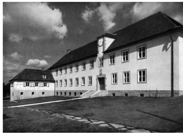
Abb. 5 Leonberg, Verwaltungsgebäude der Bausparkasse; Willem Bäumer, 1933-1934, Eingangsseite von Südosten
