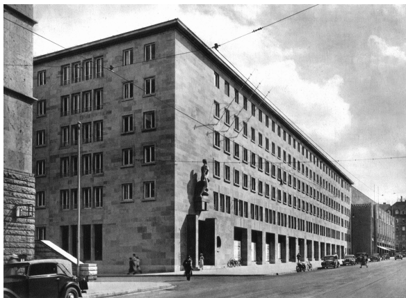
Abb. 2 Stuttgart, Verwaltungsbau der technischen Werke; städtisches Hochbauamt, Oskar Schmidt, 1934-1936, Nordansicht von der Lautenschlagerstraße
