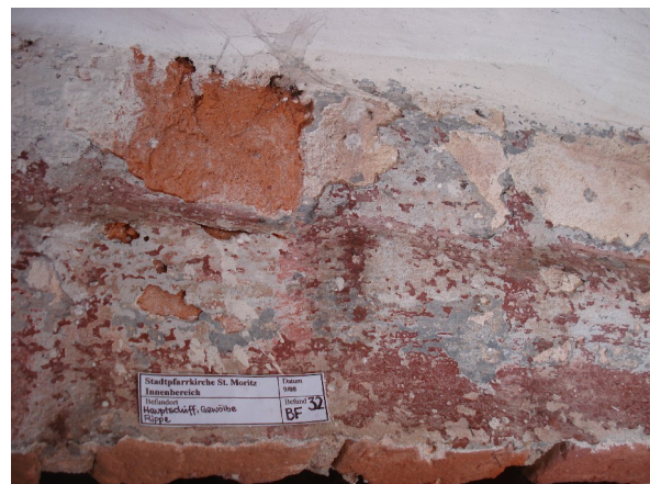
Abb. 11: Stadtkirche St. Moritz Mittenwalde; Detailaufnahme der Fassungsreste auf einem Rippenstein im Mittelschiff, Erstfassung: graue Kalkfarbe, (Andreas Huth, Lukas Böwe)
