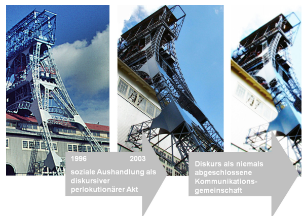
Abb. 6: Diskurs als niemals abgeschlossene Kommunikationsgemeinschaft - der Korrosionsschutz für das denkmalgeschützt Fördergerüst der Schachanlage Am Petersenschacht in Sondershausen als Beispiel für die soziale Aushandlung von Konservierung-Restaurierung (Fotos: Bernhard Mai, Kornelius Götz)
