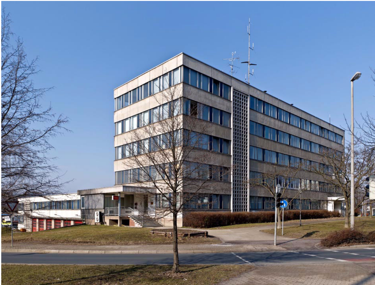
Abb.8: Gera, Berliner Straße 153, Feuerwache, Ansicht von Westen, 2011.
