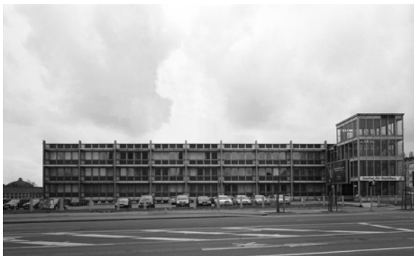
Abb.10: Leipzig, Arno-Nitzsche-Straße 43, Forschungsgebäude des VEB Metalleichtbaukombinat, Ansicht von Südosten, 2002.
