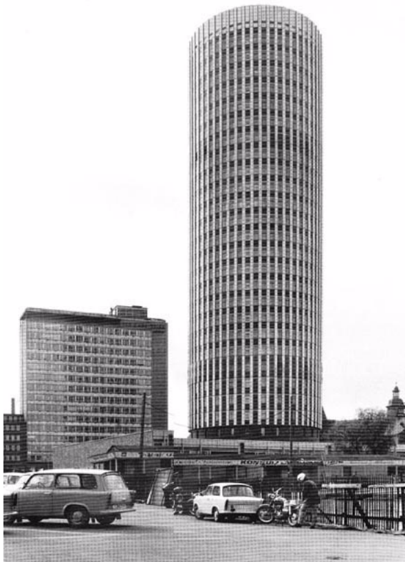
Abb.1: Jena, Leutragraben 2, 4 und 1, 1. und 2. Forschungshochhaus des VEB Carl Zeiss, Ansicht von Osten, 1970er Jahre.
