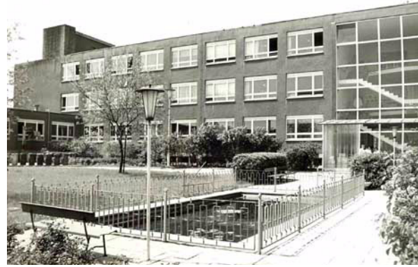
Abb.4: Bad Langensalza, Tennstedter Straße 8-9, Bezirksinstitut für Veterinärwesen, Ansicht von Südwesten, vor 1979.
