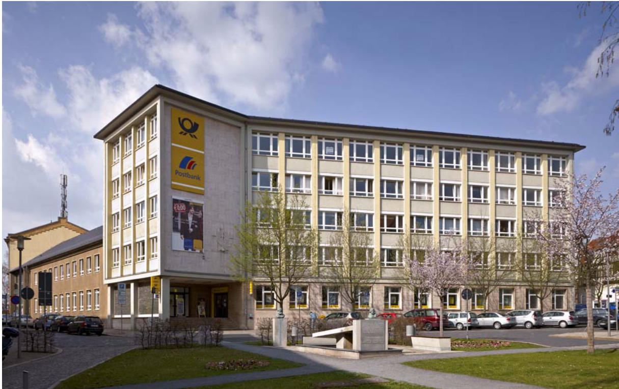
Abb.2: Nordhausen, Lutherplatz 5, Postamt, Ansicht von Osten, 2011.
