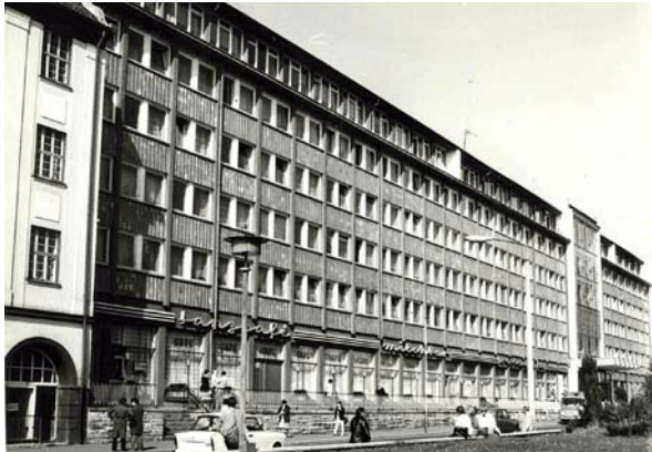
Abb.3: Sonneberg, Bahnhofstraße 66, Rat des Kreises, Ansicht von Südwesten, vor 1989.
