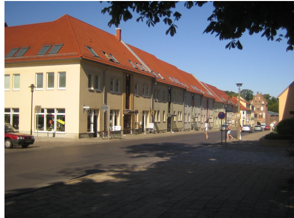
Abb. 2 Templin, Mühlenstraße, Blockrandschließung in Anlehnung an die alte Bebauungsstruktur, nach 2000.
