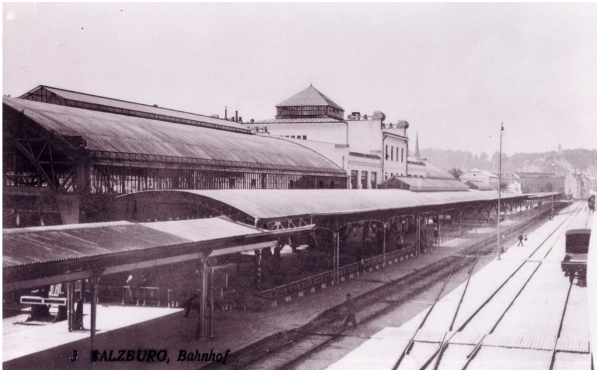
Abb.2: Gesamtansicht des Mittelbahnsteigs am Salzburger Hauptbahnhof, um 1910, Blick Richtung Südosten (Archiv Hans und Ulrike Schrott).
