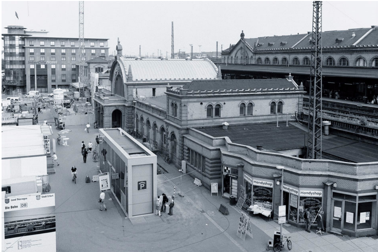
Abb.1: Der Erfurter Verbundbahnhof mit seitlichem Empfangsgebäude und Inselbahnsteig vor dem Abriss, 2003, Blick Richtung Osten (Beate Hövelmans).
