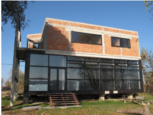
Abb. 8, Treći Beograd, Gebäude an der Donau
