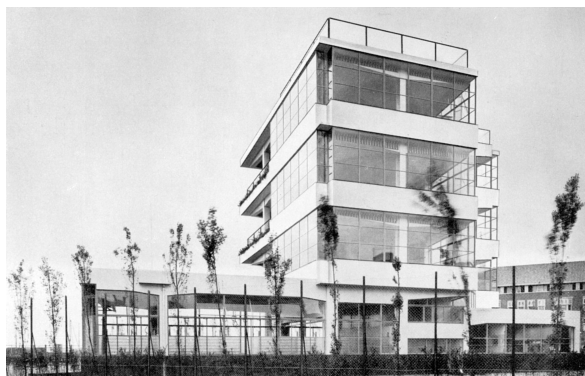
Abb. 1: Johannes Duiker (1890-1935), Open-air School Amsterdam, Nordostansicht, links die Spielhalle
