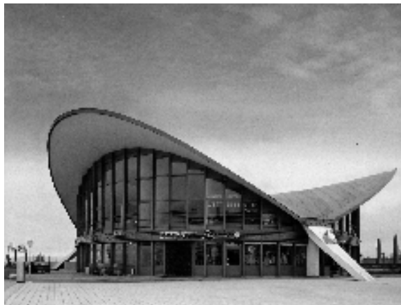
Abb. 11 Rostock-Warnemünde, Gaststätte „Teepott“, 1968, Zustand nach Sanierung 2002
