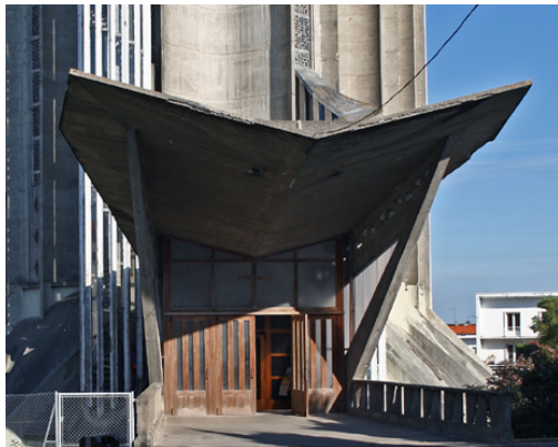
Abb.20: Kirche Notre Dame: Portalvorbau vor der Restaurierung (2007).
