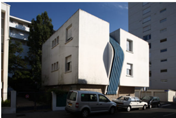
Abb.8: Wohnhaus Le Grille-Pain (1953-1956, Pierre Marmouget, Édouard Pinet).
