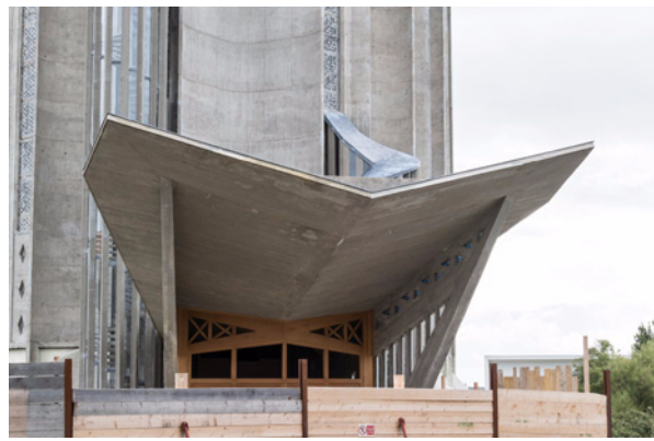
Abb.23: Portalvorbau nach der Restaurierung (2015).
