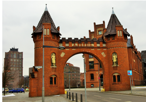
Abb.2: Borsigwerke Tegel mit Eingangstor und Verwaltungsturm. (Foto der Autorin, 11. Februar 2014)
