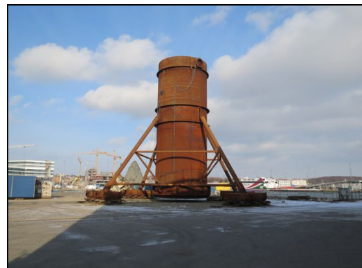
Cofferdam am Hafen von Aarhus
