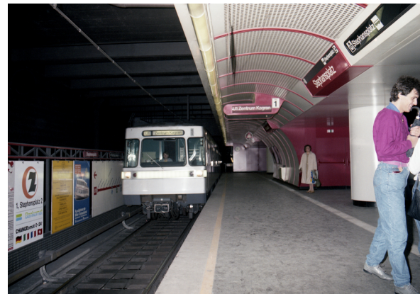
Abb.9: U-Bahnhof Stephansplatz, Wien. Bahnsteigbereich mit einfahrendem Zug. Aufnahme 1986, aus: Bildarchiv/ Wiener Linien.
