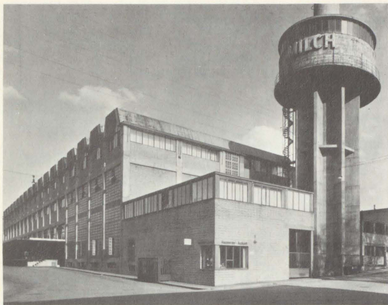
Otto Ernst Schweizer, Milchkhof, Nürnberg, Betriebsgelände 1930
