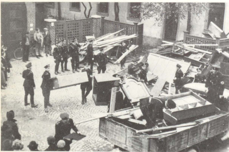
Zerstörung der Synagoge in Hof, November 1938. Foto Stadtarchiv Hof
