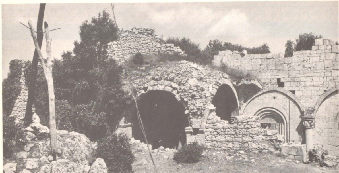
Abb. 2 Westfassade der dreischiffigen Basilika und Vorhalle
