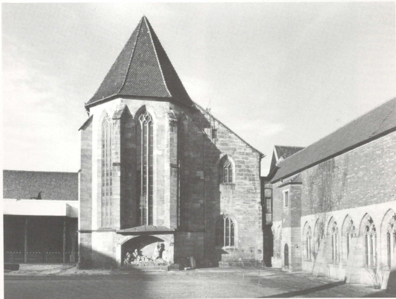
Blick vom Hof nach Westen auf die Apsis der Kartäuserkirche nach dem Wiederaufbau.
