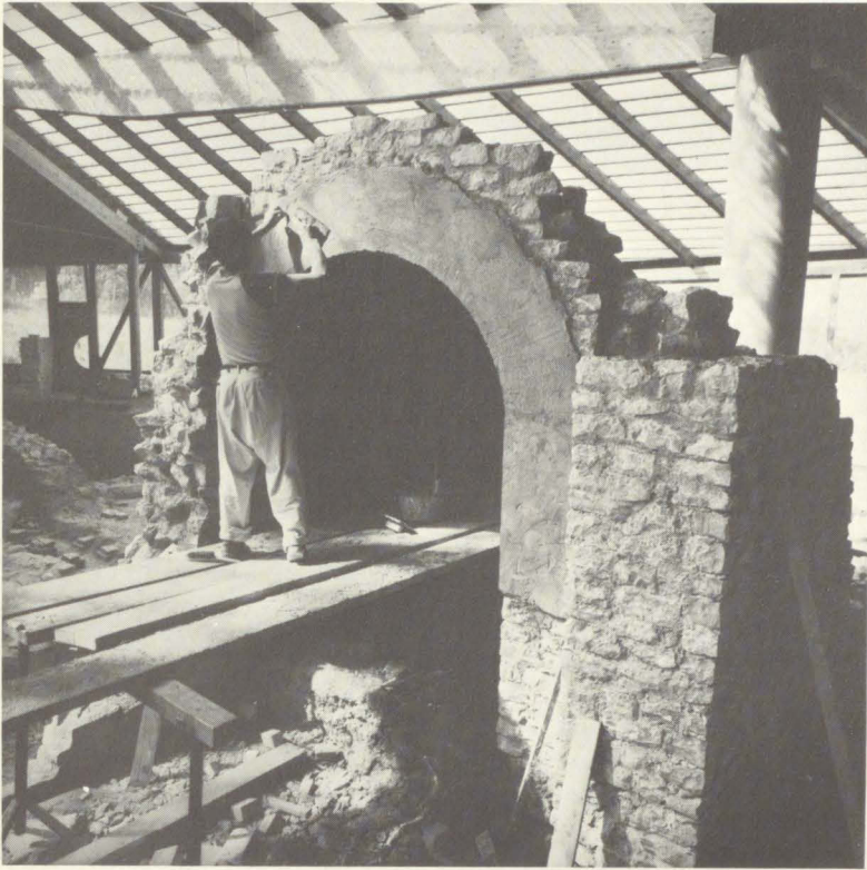
Über einem Wasserbecken der Weißenburger Thermen wird eine kleine Apsis rekonstruiert. Foto Bayer. Landesamt f. Denkmalpflege.
