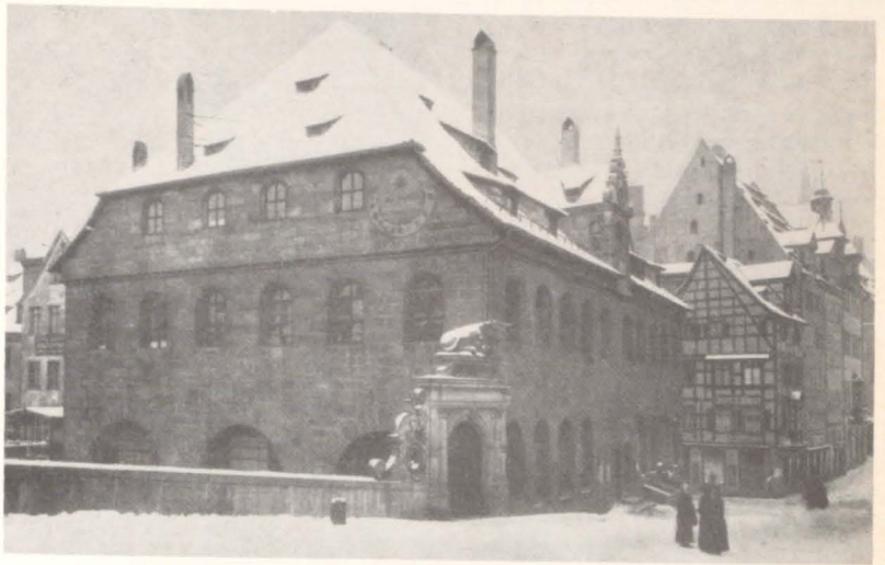
Das alte Fleischhaus an der Fleischbrücke. Erstes Domizil des Bayerischen Gewerbemuseums
