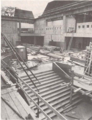
Blick in die neue Eingangshalle: Links im Vordergrund die Treppe in das Museumsforum und zum Kartäuserbau. Rechts, an der Stelle, wo die Leiter lehnt, wird eine halbrunde Treppe entstehen, die direkt in die Gemäldegalerie führt.
