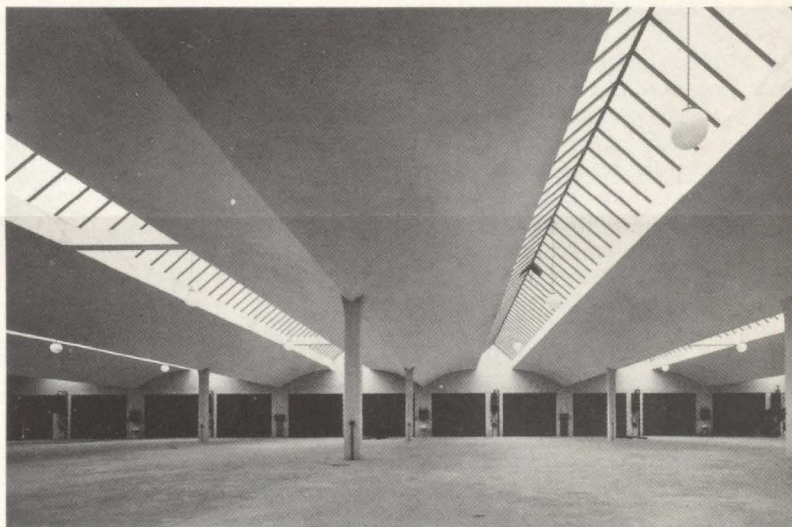
Nürnberg, »Poststadt« an der Allersberger Straße, Kraftwagen-Einstellhalle
