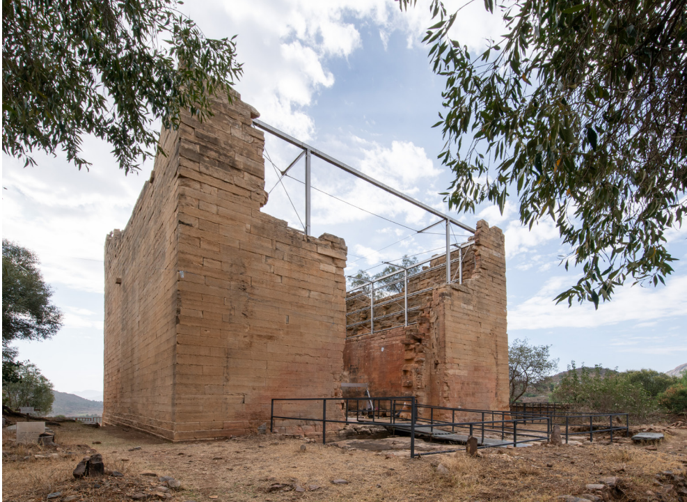
▲ Abb. 3 Der Große Tempel von Yeha mit dem Edelstahlgerüst im Inneren, Blick von Nordwesten (DAI/J. Kramer)
