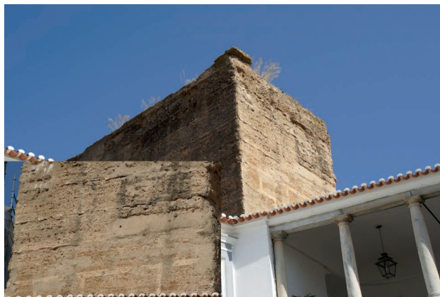
Fig. 4. Castillo de Moura (Baixo Alentejo, Portugal), Torre albarrana, Detalle de los restos de decoración de falso despiece de sillares. Fotografía: Dolores Villalba Sola, Agosto, 2011.
