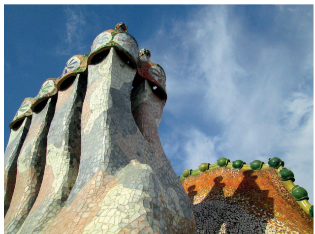
Abb. 9. Barcelona, Casa Batlló , Dach und Schornsteine, 1904-06. Foto: Miriam Minak, Oktober 2014.
