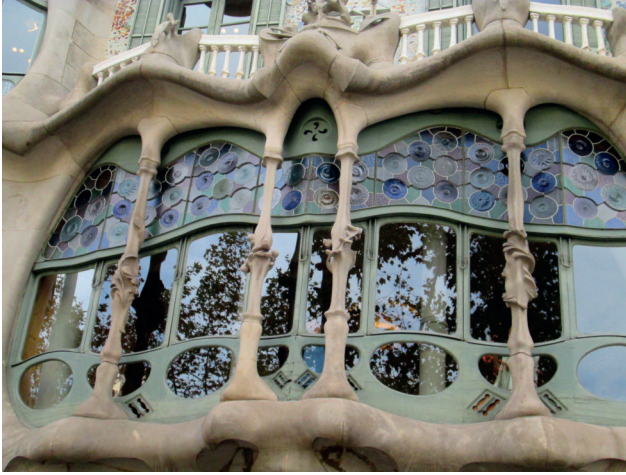
Abb. 10. Barcelona, Casa Batlló, Detail, verglaste Erkerfront mit Schiebefenstern, 1904-06. Foto: Miriam Minak, Oktober 2014.
