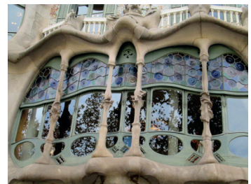
Fig. 9. Barcelona, Casa Batlló, detalle, Ventala corredizo de lado frontal, 1904-06. Foto: Miriam Minak, octubre 2014.
