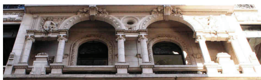
Abb. 10. Buenos Aires, Società Unione Operai Italiani, Detail der Fassade, 1913. Foto: Bianca Schäfer, 18.06.2009.
