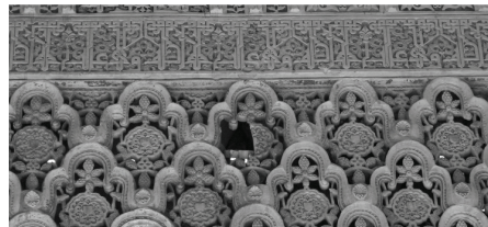
Fig. 7. Alhambra, Patio de los Leones, paño de sebka roto en el área del pabellón occidental, estado del 2008. Fotografía: Francine Giese-Vögeli, diciembre 2008.
