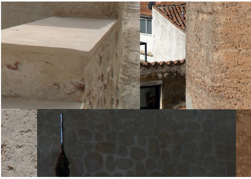
Abb. 1. Beispiele verschiedener Arten des Schein-Mauerverbandes aus almohadischer Zeit. Oben links: Alcazaba von Badajoz, Kombination von horizontalen Streifen und Scheinquaderverband. Oben rechts: Rundturm der befestigten Anlage von Cáceres, Detail des Scheinquaderverbandes. März 2012. Unten links: Burg von Baños de la Encina (Jaén), Detail des Scheinverbandes mit Fischgrätenmotiv. Mai, 2012. In der Mitte: Alcazaba von Badajoz, Beispiel eines vorgetäuschten Bruchsteinmauerverbandes. März 2012. Unten rechts: Burg La Mola (Novelda, Alicante), Scheinverband mit eingeschriebenen kreuzförmigen Motiven. August 2012. Fotos: Dolores Villalba Sola.
