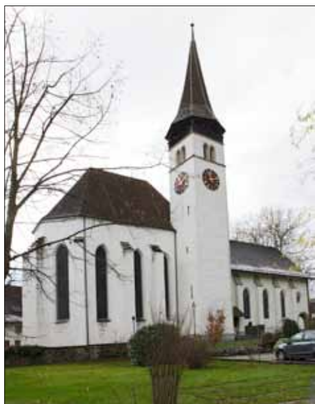
△ Abb. 1: Die heutige Kirche Interlaken mit dem Chor und dem Glockenturm der Zeit um 1300 sowie dem zwischen 1909 und 1911 erbauten Schiff. Blick nach Südwesten.
