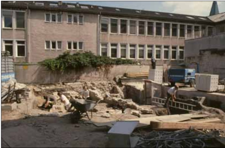
Abb. 2: Grabungsfoto der beiden Hinterhofparzellen Rathausplatz 14 Ost und West nach Norden. Die rezente Mauer im Hintergrund sitzt auf der Immunitätsmauer des Klosters Abdinghof.
