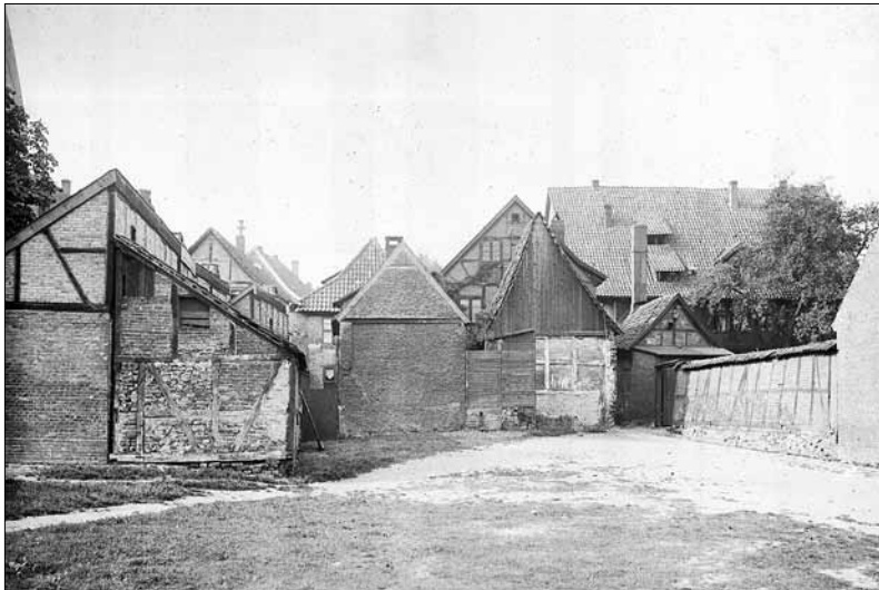
Abb. 5: Bei der St. Johanniskirche 19, Budenbebauung, teilweise abgerissen, Blick von der Ilmenaustraße 11, um 1900.
