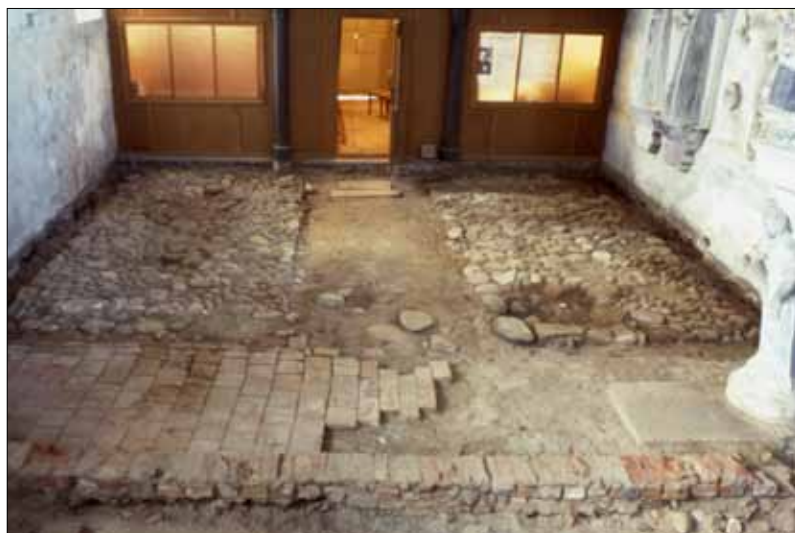
Abb. 1: Beesdau, Dorfkirche. Innenraum mit freigelegten älteren Feldstein- und Backsteinfußböden (Blick nach Westen).
