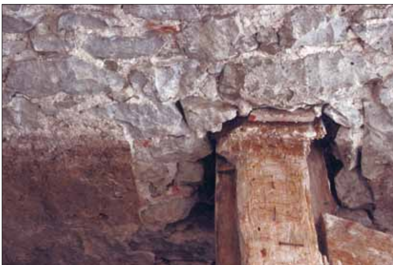
Abb. 4: Stadt Zug, Zeughausgasse 21, Bauuntersuchung 2006. In die massiv gemauerten Fassaden wurden die gemäß dendrochronologischer Untersuchung 1525 geschlagenen Boden- beziehungsweise Deckenbalken eingemauert. Nach dem Schwinden der Balken entstanden zwischen Balken und Mauermörtel dünne Hohlräume.
