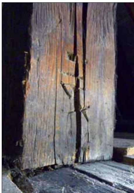
Abb. 1: Stadt Basel, Lohnhof (ehemalige Stiftsbibliothek), Dachwerk von 1440. Ständer mit römischer Nummerierung und Dachseiten-Zuordnung (quadratische Kerbe über der Ziffer). Am Riss, der das Bundzeichen gesprengt hat, zeigt sich, dass der Ständer saftfrisch verarbeitet worden ist.
