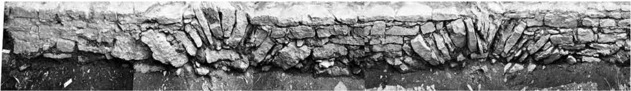
Abb. 3: Entlastungsbögen des Nordfundaments.
