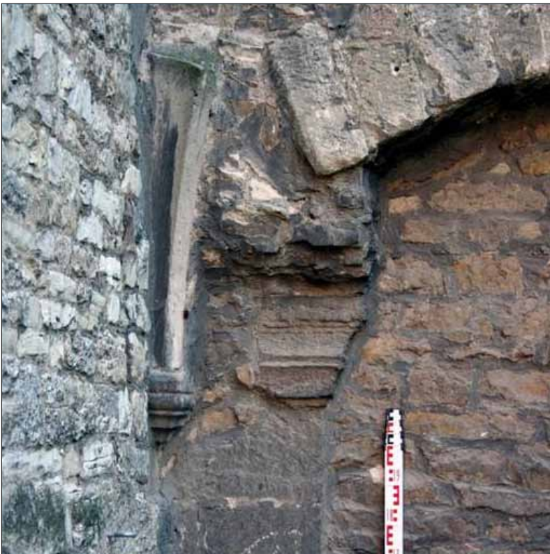
Abb. 5: Nordwestlicher Vierungspfeiler, von außen sichtbar.
