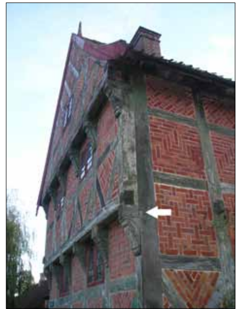
Abb. 16: Stockwerkartige Vorkragung an der Apotheke aus Aalborg, heute in Den Gamle By. Das Giebfeld ruht auf vorgenagelten, quadratischen Holzklötzen (Pfeil), die Geschossbalken sind hofseitig durch die Wandständer gesteckt und mit Zapfenschloss gesichert.
