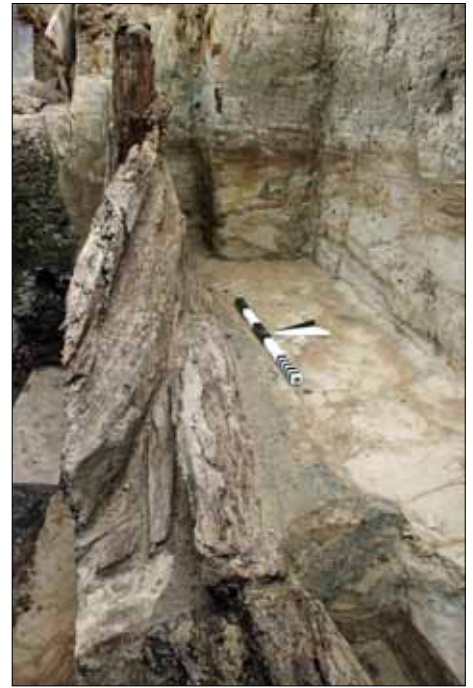
Abb. 9: Lübeck, Braunstraße 30A. Die noch in vier Lagen erhaltene, leicht verdrückte Südwand des Holzkellers aus blockbauartig übereinander gelegten Erlenhölzern.
