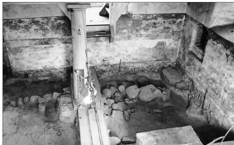
Abb. 3: Wolkenberg, Dorfkirche. Unterlegsteine der Fundamentierung einer hölzernen Vorgängerkirche des 14. Jahrhunderts im Befund.
