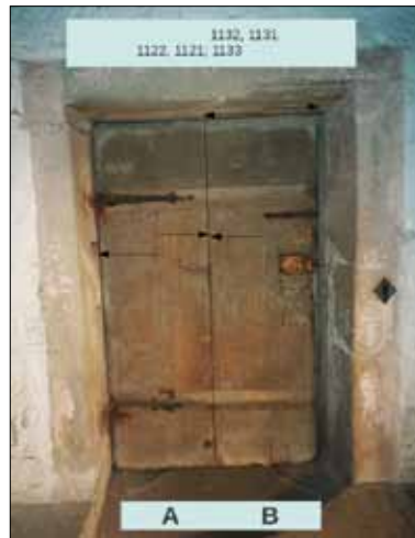
Abb. 7: Tür aus der Zeit um 1170 vom Südwestjoch des Kreuzgangs zum Langhaus (Nr. 4), rechts vom Kircheninneren, links vom Kreuzgang aus gesehen. Bezeichnung der Bohlen und Mess-Strecken.
