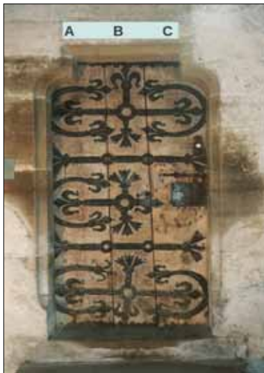
Abb. 10: Sakristeitur (Nr. 6) aus der Zeit um 1300 im Südgiebel des Querschiffs von innen und außen. Die Mess-Strecken für die Nr. 121 bis 123 wurden ausschließlich auf den Stirnseiten der Bohlen A bis C erhoben.
