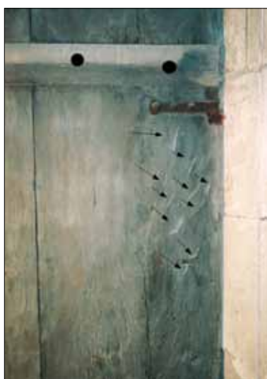
Abb. 4: Technologische Details an der nördlichen Lettnertür (Nr. 9): Auf der Innen- und der Aussenseite des Türblatts sind die Bearbeitungsspuren mit dem Breitbeil deutlich erkennbar. Die Kanten der Schlag- und Hiebsspuren wurden teilweise mit Kreide eingefärbt. Pro Bohle wurden zwei Holz-Dübel (schwarz markiert) angebracht, sie fixieren die durchgehende, eingeschobene Querleiste.
