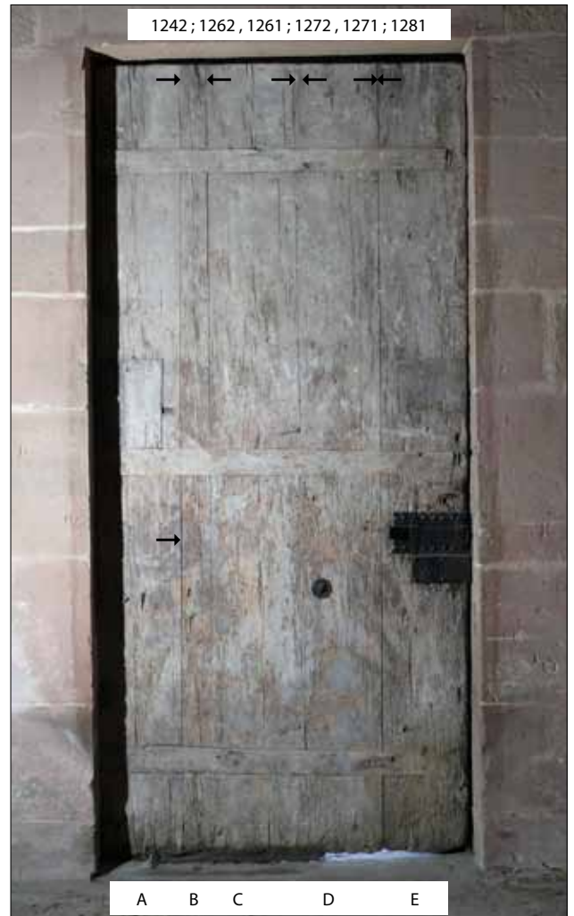
Abb. 6: Südliches Westportal der Klosterkirche (Nr. 7) mit Tor aus der Zeit um 1170 von außen und innen. Bezeichnung der einzelnen Bohlen und Mess-Strecken.
