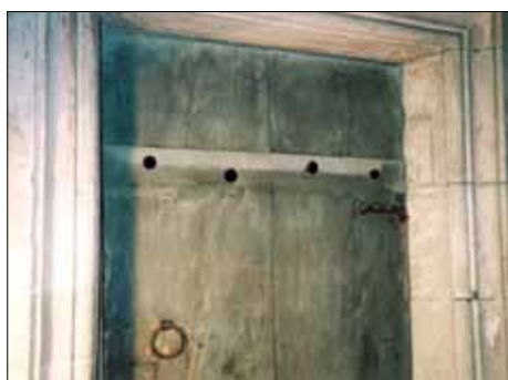
Abb. 4: Technologische Details an der nördlichen Lettnertür (Nr. 9): Auf der Innen- und der Aussenseite des Türblatts sind die Bearbeitungsspuren mit dem Breitbeil deutlich erkennbar. Die Kanten der Schlag- und Hiebsspuren wurden teilweise mit Kreide eingefärbt. Pro Bohle wurden zwei Holz-Dübel (schwarz markiert) angebracht, sie fixieren die durchgehende, eingeschobene Querleiste.
