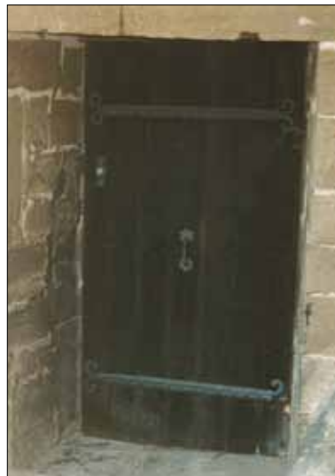
Abb. 10: Sakristeitur (Nr. 6) aus der Zeit um 1300 im Südgiebel des Querschiffs von innen und außen. Die Mess-Strecken für die Nr. 121 bis 123 wurden ausschließlich auf den Stirnseiten der Bohlen A bis C erhoben.
