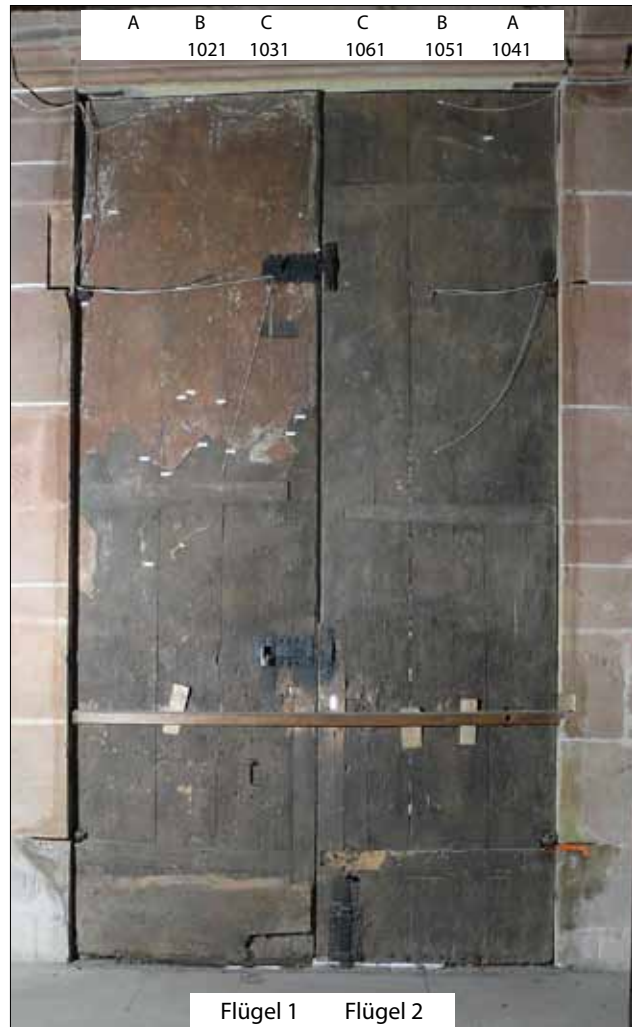
Abb. 5: Hauptportal der Klosterkirche mit den Flügeln Nr. 1 und 2 aus der Zeit um 1170 von außen und innen. Bezeichnung der einzelnen Flügel, Bohlen und Mess-Strecken.
