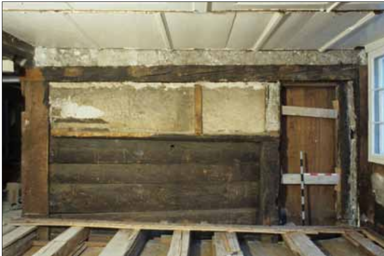
Abb. 7: Haus St.-Oswalds-Gasse 10, Zug ZG, Blick nach Westen an die nordwestliche Kammer im zweiten Obergeschoss. Zum Originalbestand von 1447 gehören fünf Wandbohlen, Süd- und Nordständer (nur wenig sichtbar), Türpfosten, Geschossrähme und Bundrähm. Die Wandbohlen sind im Süden (links) in den Ständer eingenuet. Die oberste und unterste Bohle zogen ursprünglich durch den Türpfosten hindurch bis in die Nut des Nordständers. Auf der obersten Bohle sitzt das Geschossrähm, auf dem ehemals die Bodenbretter des Dachgeschosses auflagen. Die Ständer, die oben durch ein Bundrähm abge bunden sind, ragten ursprünglich als Kniestock in dieses Geschoss hinein.
