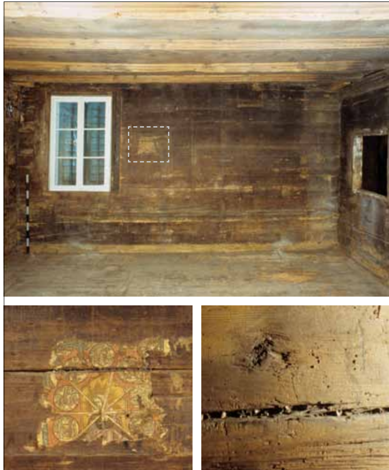
Abb. 6: Haus Unterblacki 1510d, Unterägeri ZG, Blick nach Süden an die freigelegte Stubenwand. Kleines Bild unten links: Der Einblattdruck mit der Darstellung der Sieben Schmerzen Mariens wurde zwischen 1510 und dem beginnenden 17. Jahrhundert auf die Blockwand geklebt (vgl. Markierung). Kleines Bild unten rechts: In einem Schwundriss der Stubenwand deponierte menschliche Zähne.
