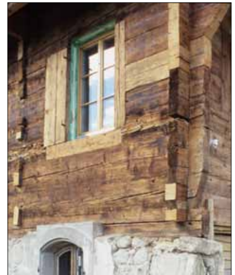
△ Abb.5: Eckgewält und Binnenwandvorstöße bei Haus Unterblacki 1510d, Unterägeri ZG. Aufnahme nach der Restaurierung des Hauses 2009.
