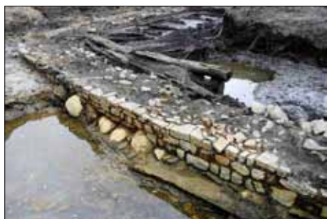
△ Abb. 5: Außenseite der Umfassungsmauer der zweiten Phase der Burg. Gut zu erkennen sind die bearbeiteten Grauwacken des aufgehenden Mauerwerks sowie das Fundament, das im Vordergrund aus größerem Grauwackebruch mit „Holzstabilisierung“ und im Hintergrund aus großen Findlingen gebildet wird.
