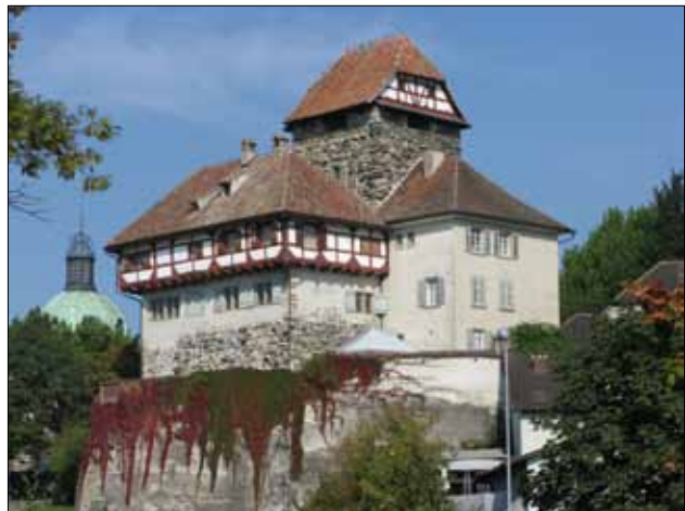
Abb. 13: Frauenfeld, Kanton Thurgau (Zustand 2009). Der 1345/46d gezimmerte Fachwerkaufbau fasste zwei ältere Bauten zusammen. An der Turmmauer ist der Austritt auf einen Wehrrerker oder einen Laubengang sichtbar.
