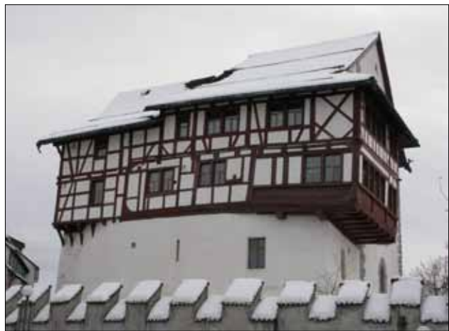
Abb. 12: Zug, Kanton Zug (Zustand 2010). Der eingeschossige, auf dem Bild dunkel hinterlegte Holzaufbau entstand 1353/55d im Zug des Wiederaufbaus der Burg Zug. Noch im Zeitraum zweite Hälfte 14. bis mittleres 15. Jahrhundert wurde er nach Osten erweitert. Bis ins letzte Drittel des 18. Jahrhunderts vorgenommene Ausbauten führten zum heutigen Erscheinungsbild des Holzbaus.
