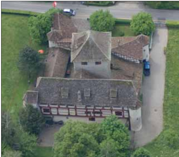
Abb. 14: Hegi, Kanton Zürich (Zustand 2005). Luftansicht von Norden. Das 1458/59d gebaute sogenannte Ritterhaus überragt die Ringmauer als Fachwerkbau um zwei Geschosse und nimmt die gesamte Nordseite der Burganlage ein.
