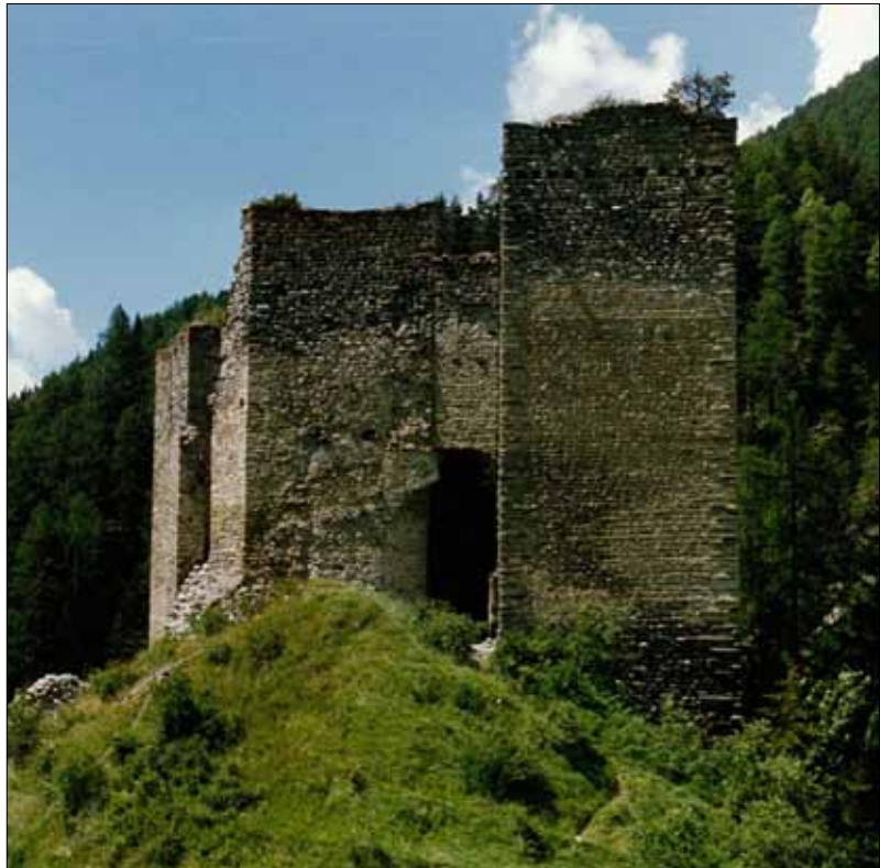
Abb. 2: Tschanüff, Kanton Graubünden (Zustand 1996). In der Ost-Fassade sind aufgehend erhaltenen Mauerpartien von 956/57d erhalten. Der 1254d errichtete Hauptturm wies eine Wehrlaube auf, die von der Südwand her zugänglich war.
