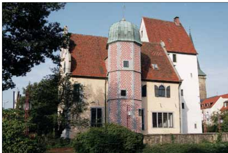
Abb. 3: Osnabrück, Ledenhof (Zustand von 2006).
