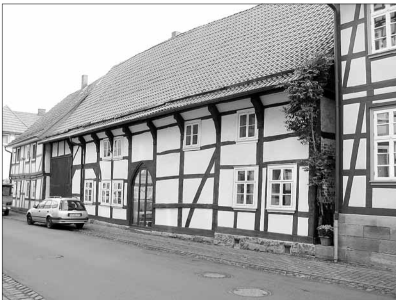
Abb. 10: Hedemünden, Landkreis Göttingen. Traufenständiges Fachwerkhhaus des 16. Jahrhunderts. Links neben dem Eingang die heute verbaute, ursprüngliche Toreinfahrt, rechts neben dem Eingang ein Keller mit ehemaliger Stube.
