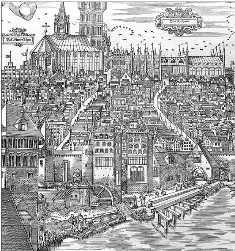
Abb. 9: Ausschnitt aus der Stadtansicht von Elias Diebel von 1552 mit den Wassertürmen der Brauerwasserkunst und der Kaufleutewasserkunst am Hütterdamm.
