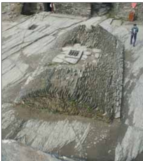
Abb. 1: Gemauerte Tankzisterne in der Burg la Roche en Ardenne.
